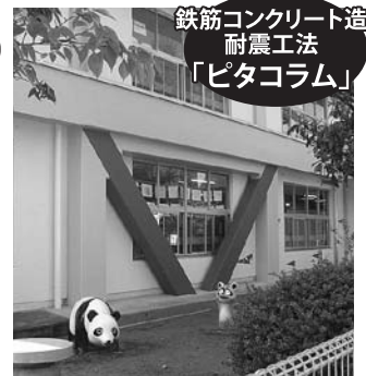
鉄筋コンクリート造 幼稚園
