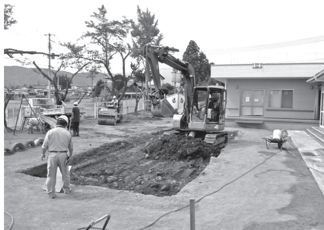
▲福島愛隣幼稚園の園庭除染作業
