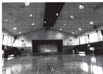
天井撤去後の屋根 面に吹付け材を塗布 し断熱性能等を確保
