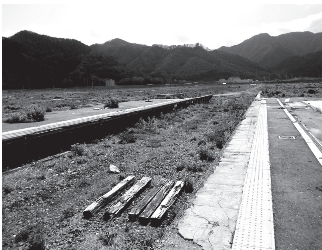
▲線路が撤去されたままの駅のホーム（H25.5）
