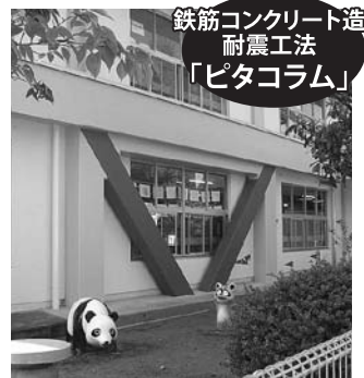
鉄筋コンクリート造 幼稚園
