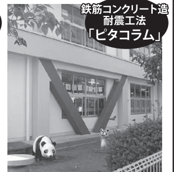
鉄筋コンクリート造 幼稚園
