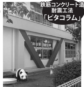
鉄筋コンクリート造 幼稚園
